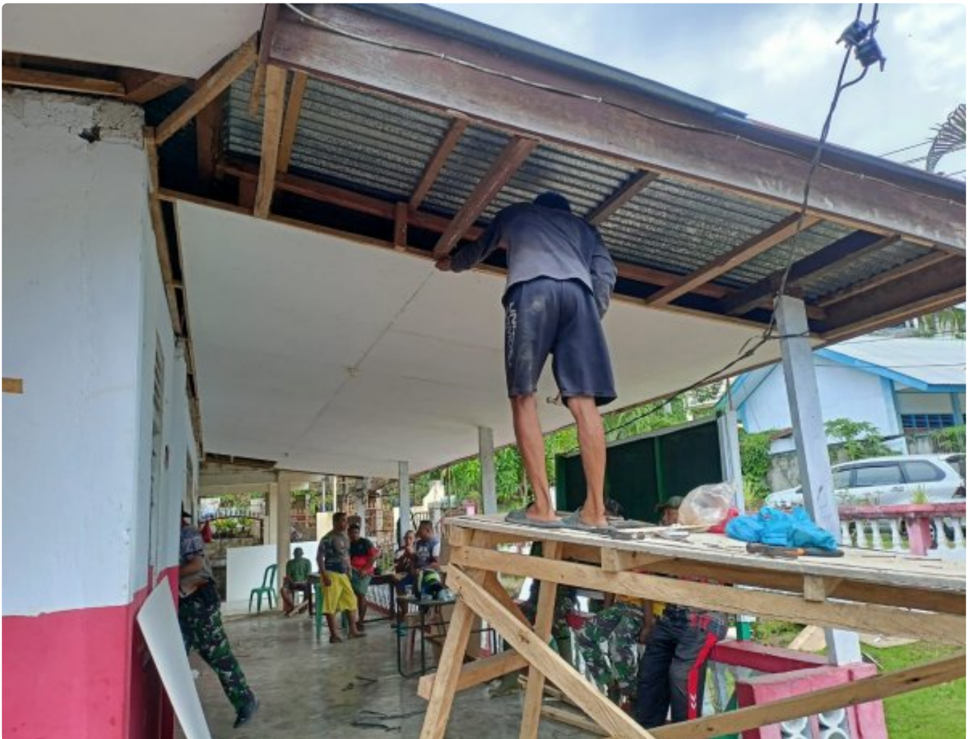
Satgas TMMD Renovasi Kantor Kelurahan Tandurusa
